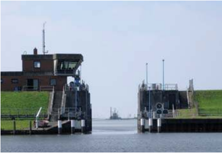
Hochwasserschutzschleuse. Im Hintergrund ist der Schwimmbagger Isern Hinnerk zu erkennen.
