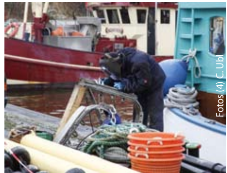
Am Kutter HUS 19 von Thorsten Laß werden Instandsetzungsarbeiten durchgeführt.
