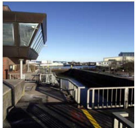
Die 1980 errichtete Schleuse verbindet den Binnenhafen mit der Unterweser.
