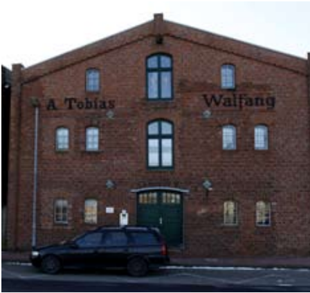
Das Gebäude der ehemaligen Reederei A. Tobias & Co., die zwei Schiffe zum Walfang im Einsatz hatte, ist direkt am Binnenhafen zu finden.
