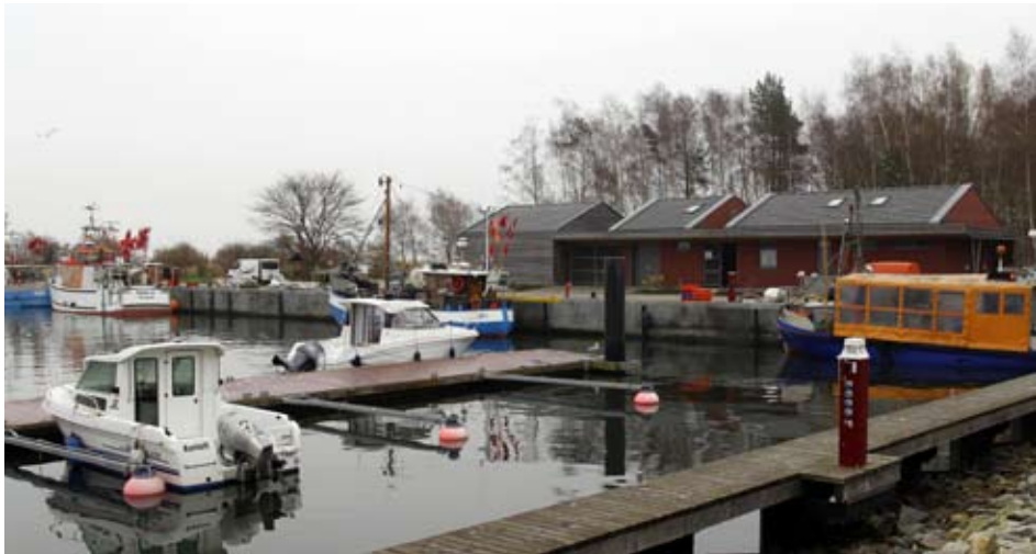
Blick auf den Hafen - im Hintergrund die von der Fischerei genutzten Gebäude mit der Kühlzelle und den Eismaschinen.
